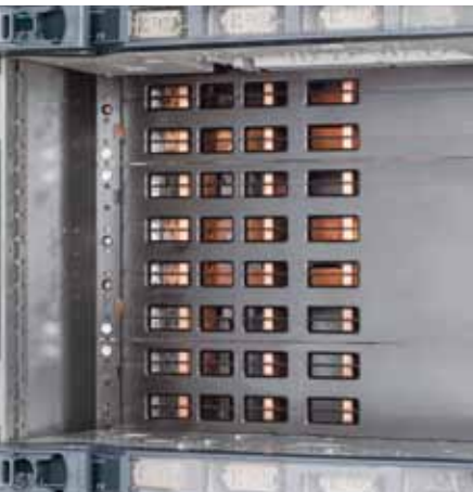
Steckschienensystem, prüffingersicher abgedeckt (IP20B).
